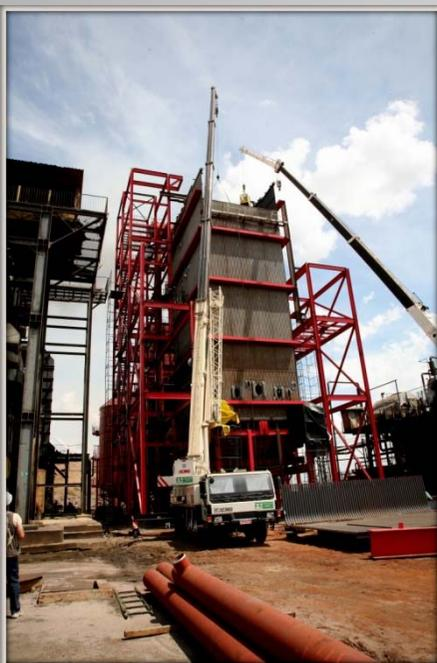
La combustion de la bagasse génère de la vapeur elle entraîne un alternateur qui produit de l'électricité.
