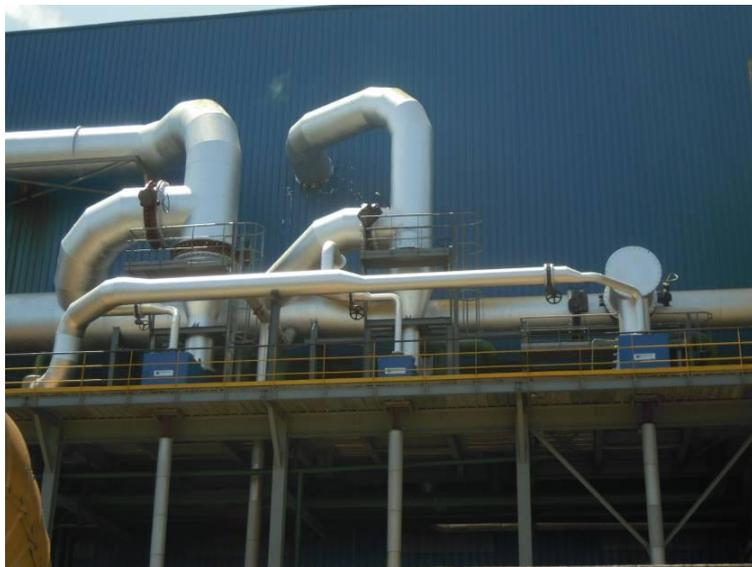
**Figure 13. Condenseurs à surface en lieu et place de condenseurs barométriques**
