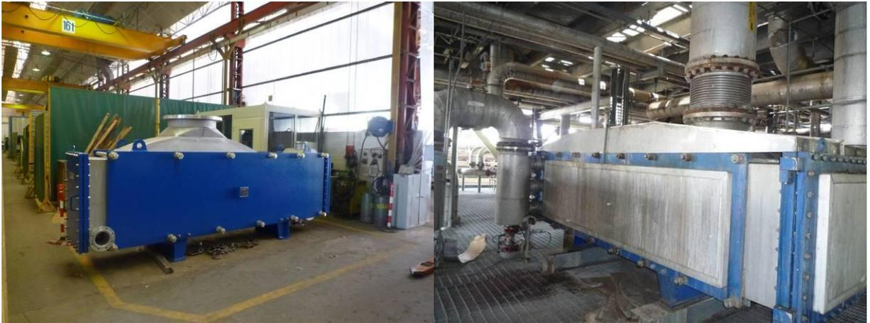
Figure 9. Réchauffeur de jus avec des vapeurs de cuite
