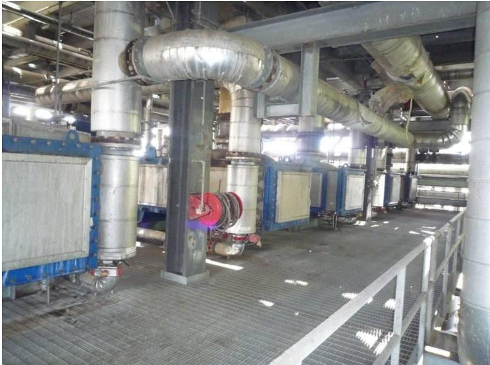
Figure 11. Ligne de réchauffage de jus sur vapeurs de prélèvement
