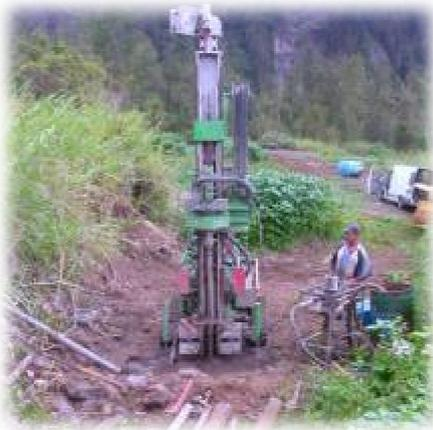
Figure 11 : Sondage par carottage
