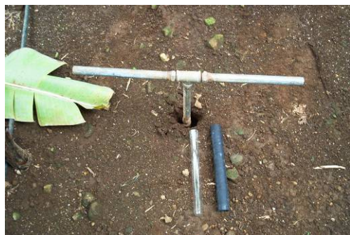
Photo 1 : tubes enterrés au ras du sol
