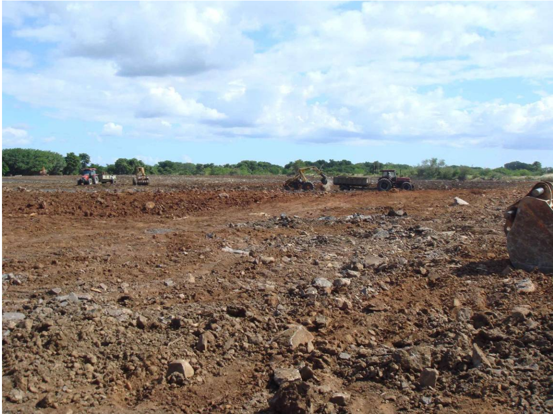
Photo 5 : Epierrage des grosses pierres avant entrée du broyeur
